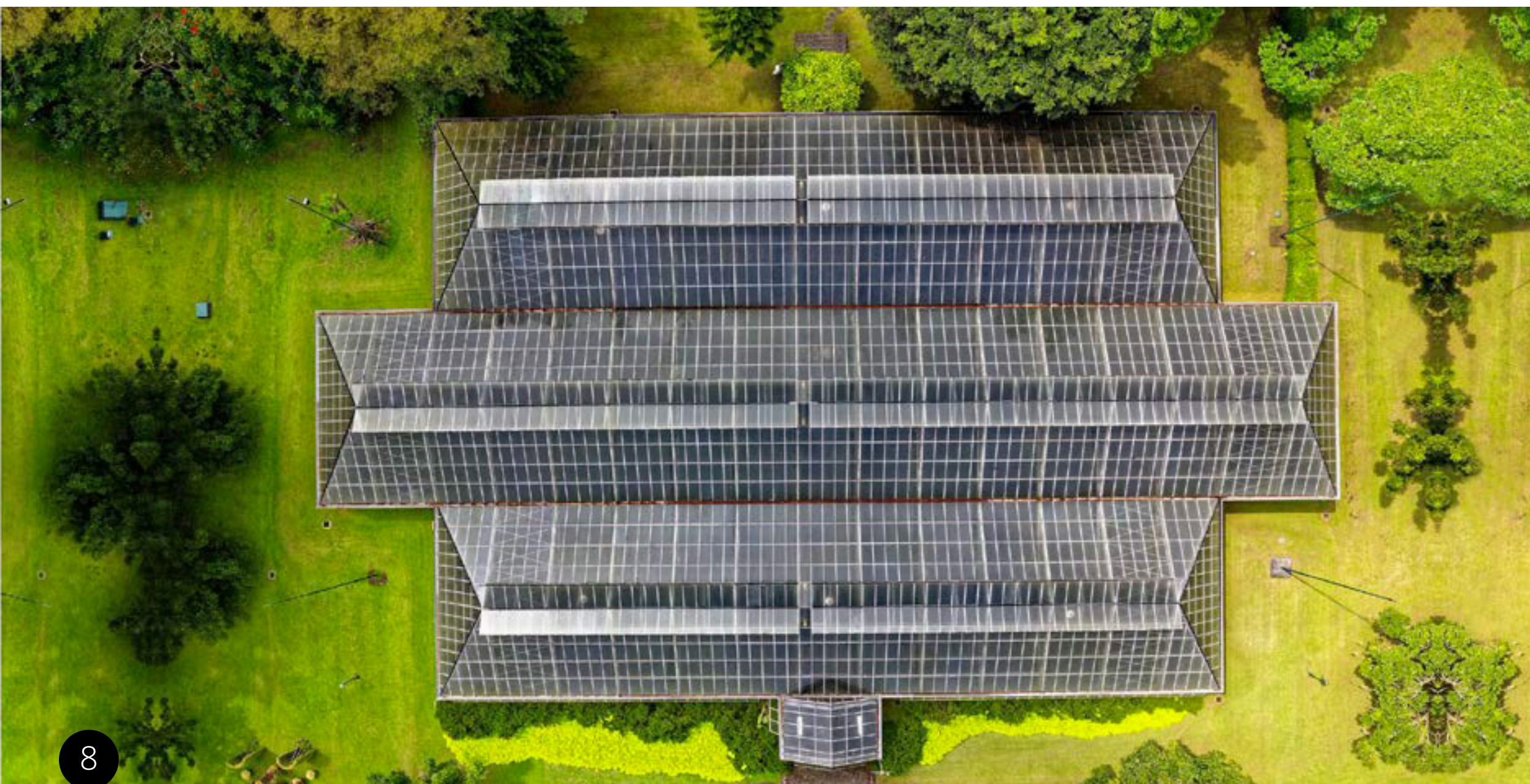
Telhado de painel solar em Sukaresmi, Indonésia
